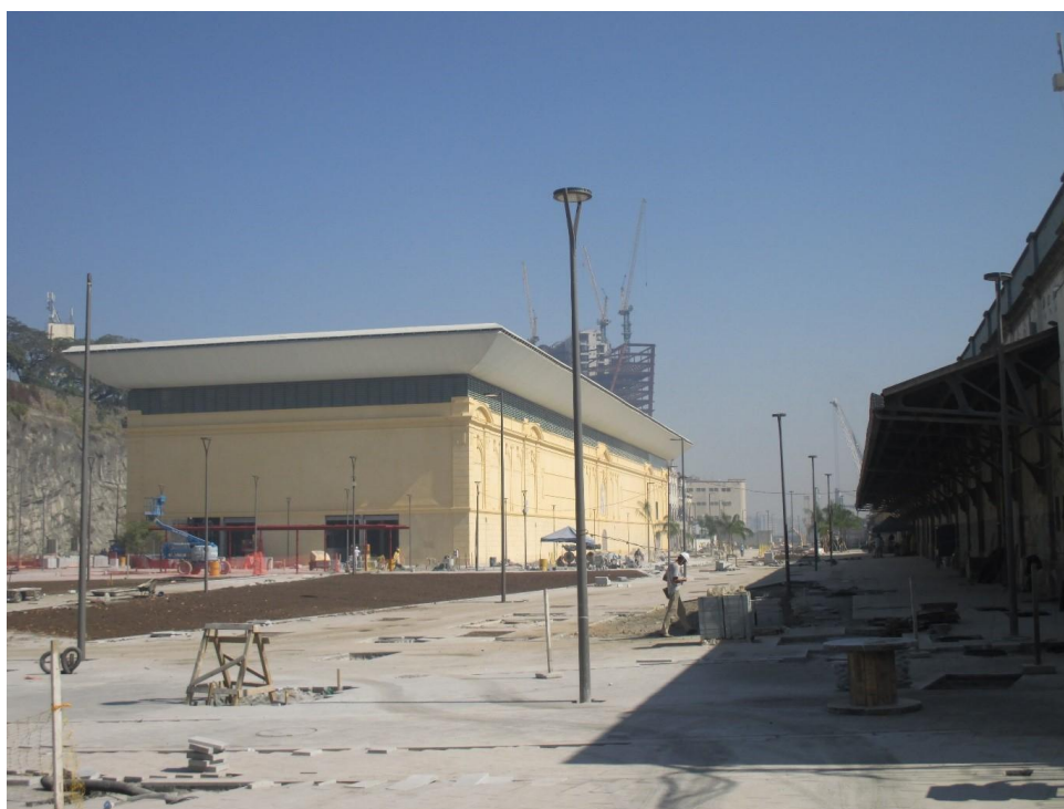
Aquário em construção
